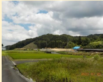
【整備箇所の遠景】
