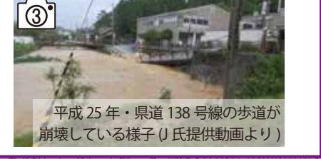
平成25年・県道138号線の歩道が崩壊している様子(氏提供動画より)
