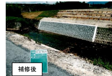
写真 護岸補修の状況(真野川)
