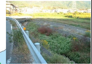
写真 藤ノ木川の河道内状況
