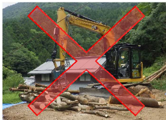
排ガス・低騒音機械確認写真
