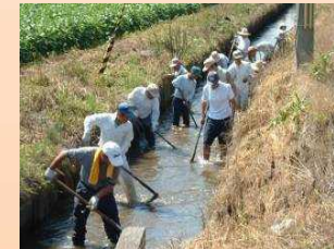
水路の泥上げ
