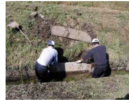
排水路の補修
