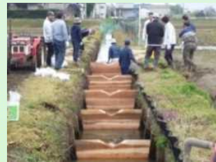
水路魚道の設置(堰上式)
