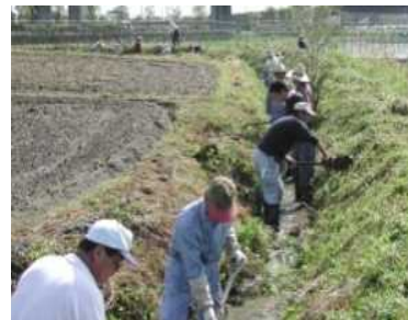
水路の泥上げ
