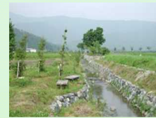
石積水路の設置
