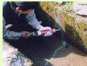
水路のひび割れ補修
