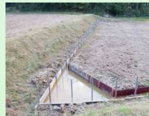
水田内水路の設置
