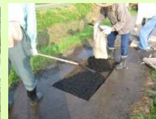
農道の部分補修
