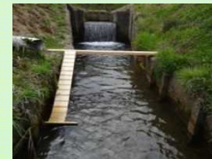
水路からの脱出施設の設置
