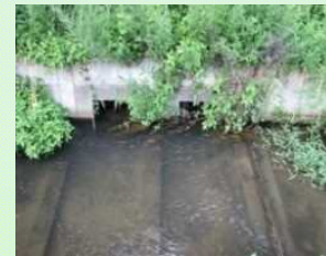
魚巣ブロックの設置
