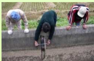
施設の機能診断
