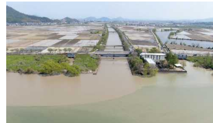
一級河川白鳥川河口の濁水発生状況(4~6月)
