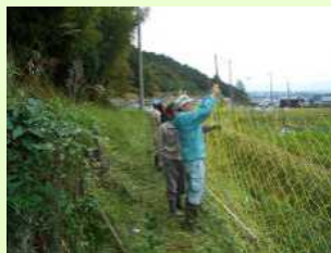
鳥獣害防護柵の補修・設置
