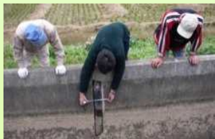
施設の機能診断
