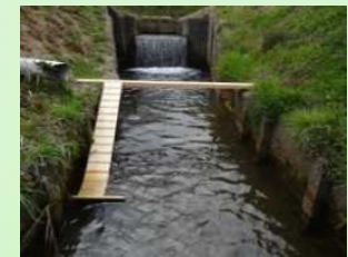
水路からの脱出施設の設置
