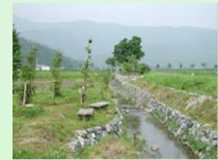
石積水路の設置
