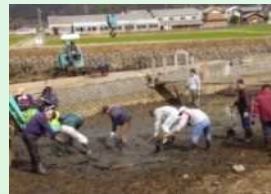
浄化池の泥上げ
