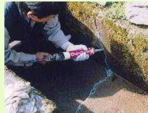
水路のひび割れ補修
