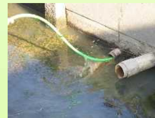
暗渠施設の清掃
