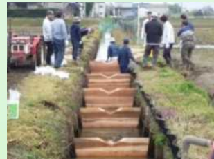
水路魚道の設置(堰上式)
