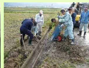
水路法面の初期補修
