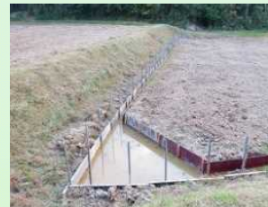
水田内水路の設置
