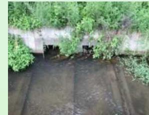
魚巣ブロックの設置
