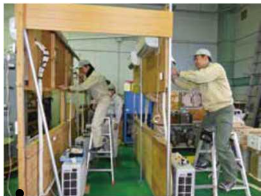
ルームエアコン設置実習
