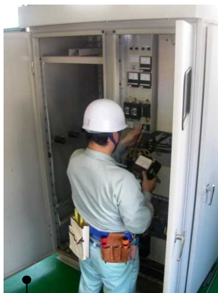
電気設備保守点検実習
