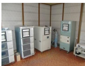
大気自動測定局の内部
