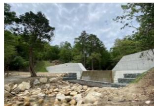
治山堰堤（下流より）
