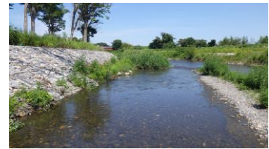
石田川多自然川づくり (環境保全カゴ型護岸) (高島市今津町福岡他)
