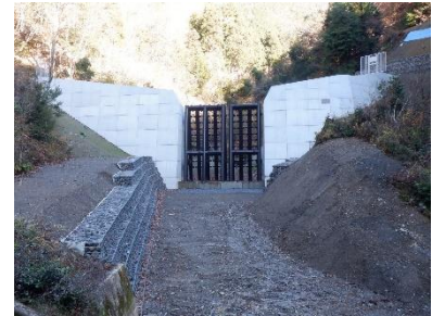
坪谷川砂防堰堤（長浜市）
