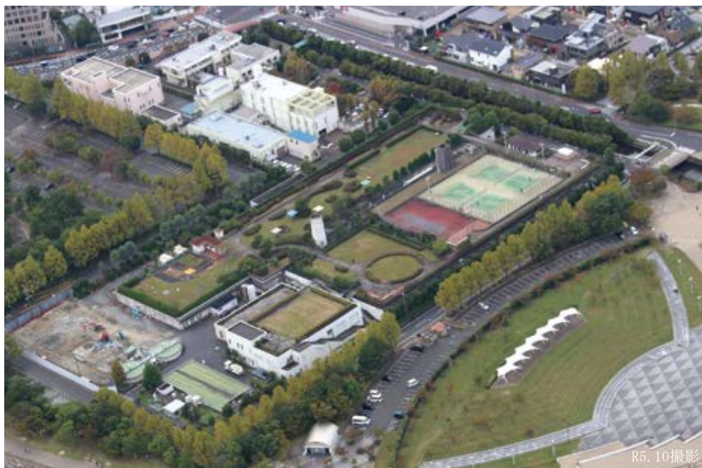
▲大津市水再生センター
