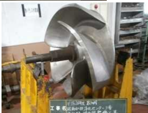
汚水ポンプの分解整備(羽根車)
