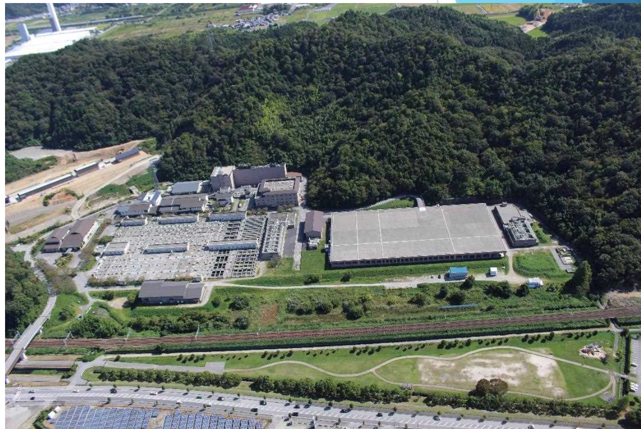
東北部浄化センター全景（彦根市）
