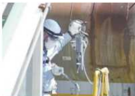
煙道排ガス調査
