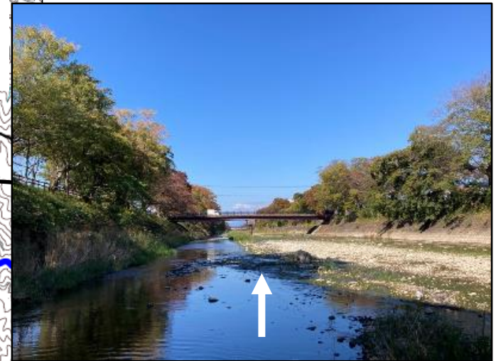
整備実施区間の改修状況
