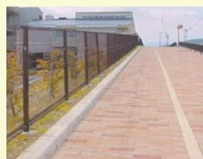
CO<sub>2</sub>が経年に伴って、空気中のCO<sub>2</sub>を吸収するという性質に着目しました。CO<sub>2</sub>と水酸化カルシウムが反応し、炭酸カルシウムを生成する中性化の過程でCO<sub>2</sub>を吸収します。更に、中性化をより進めるために産業廃棄物の下水汚泥焼却灰を利用します。この技術により、従来のものより5%以上多くのCO<sub>2</sub>を吸収・固定させることを目指しています。
