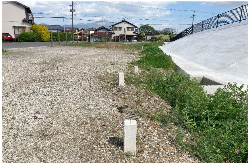
南側道路敷との 境界標
