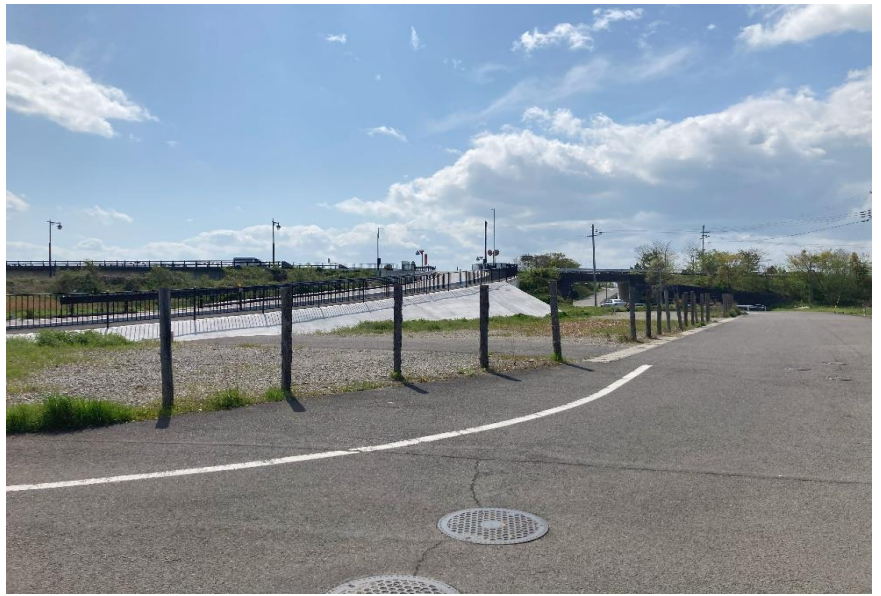
北東側より撮影
