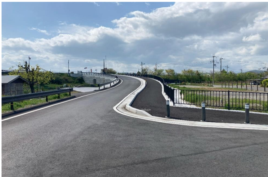
南側県道 東側より撮影
