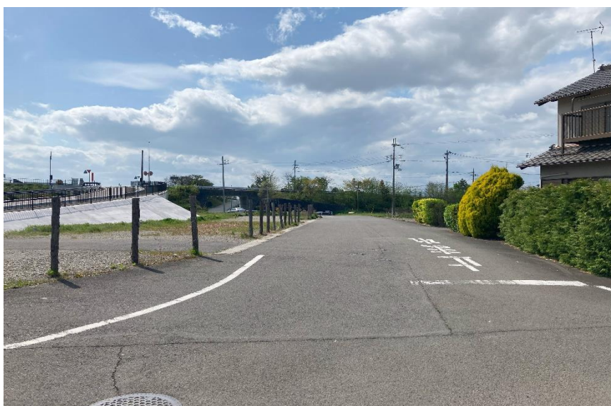
北側市道 東側より撮影
