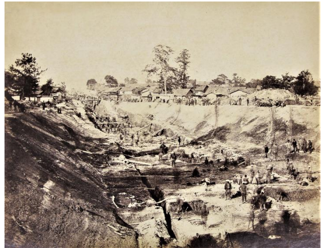
2-1 「琵琶湖疏水東口掘割工場」明治19年【資576】
