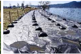
石組み護岸での遮光シートの敷設
