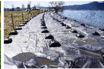
石組み護岸での遮光シートの敷設
