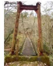
東海自然歩道吊橋
