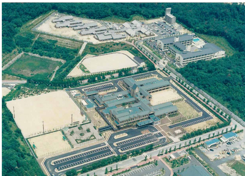
平成4年6月 滋賀県立精神保健総合センター竣工
