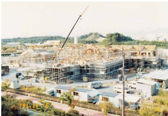
建設中の風景
