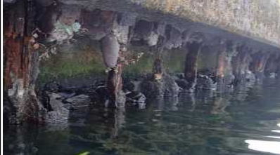
彦根港 矢板護岸
