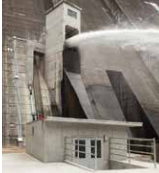
【発電設備の新設・増強】
