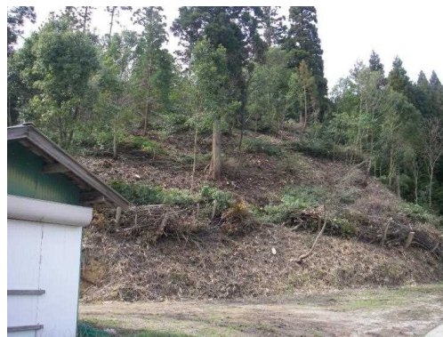
里山防災整備施工後
