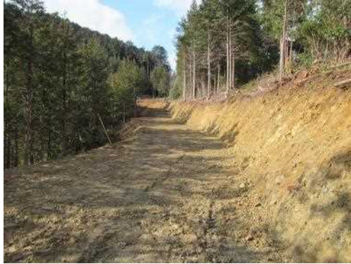
間伐材搬出道(大津市)
