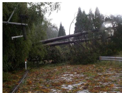
風倒木による被害(大津市)
