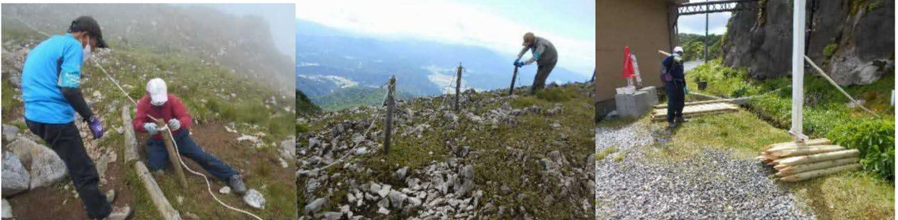
西登山道展望台付近～表登山道バイパス保護杭補修及びロープ引き換え作業を2日間、のべ10名の会員で実施しました。展望台付近は、ほとんどが使用できなく、新しいロープを引き直しました。西登山道展望台から表登山道に通ずる登山道では鉄杭が使用されていたが雪の影響か曲がって使用できないことから、山頂より木製の杭を15本程運び、交換しロープを引き換えました。また、山頂付近の保護杭・ロープの傷んだ箇所の補修作業も行いました。報告はwanちゃんでした。
