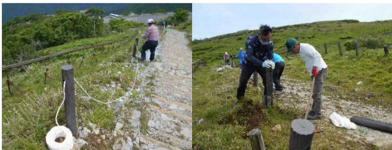
中央登山道保護杭補修及び防護ロープ引き換え作業(後半)は3日間、のべ20名の会員で行いました。2班に分かれ効率よく作業を実施しました。一班は前回引き抜き作業を実施した場所No33から、保護杭の設置作業とロープの設置作業を実施。旧擬木の間隔が狭かった箇所は、3m
