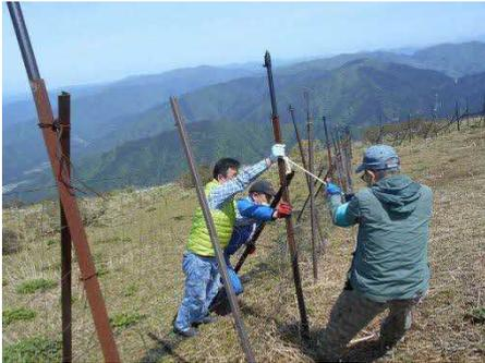
シモツケソウ再生地の防護ネット・支柱が雪により損傷したため、支柱の倒れを補修しながらネット上げ作業を並行して実施しました。イノシシが入ったと思われる土の掘り起こしが多くの場所で見られました。シモツケソウは大きな被害はないようですが、球根類の花は心配です。
