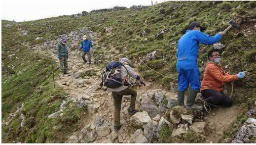
今年度はじめての保全活動である表登山道9合目付近の鉄くい・ロープの設置と西登山道および山頂周辺保護柵ロープの点検を行いました。登山者の安全確保のため、表登山道8合目から9合目付近の昨年撤去してあった鉄杭を打ち、ロープを設置しました。その後、西登山道及び山頂周辺の保護ロープの確認したところ、今年の雪でロープ切れ損傷がひどく補修が必要な箇所が多く見られました。報告はwanちゃんでした。
