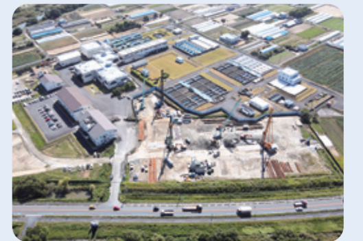
吉川浄水場耐震対策工事の様子
