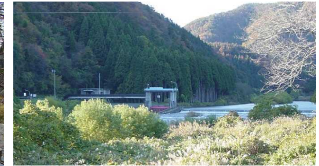
高時川頭首工
