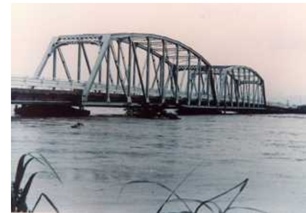
昭和50年台風6号 難波橋
