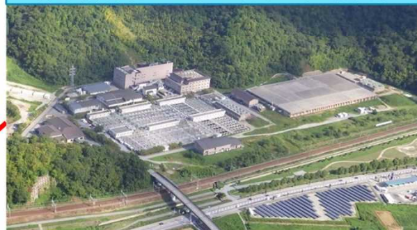
東北部浄化センター(平成3年4月供用)
