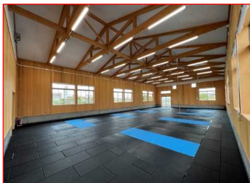
木造公共施設
