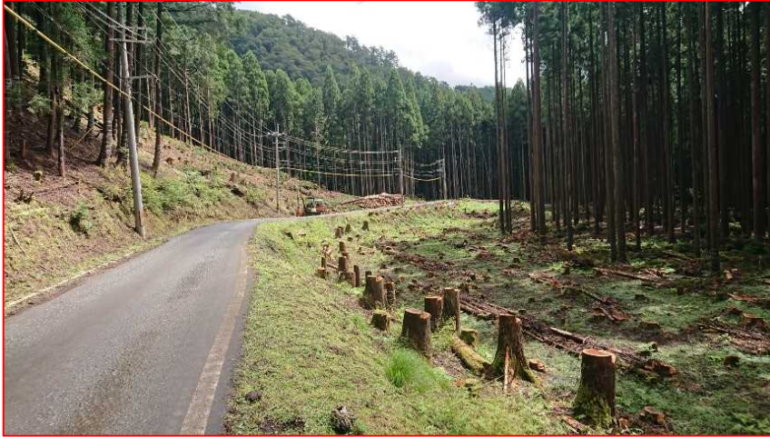
道路沿いの予防伐採を行った現場
