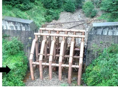
砂防堰堤で土砂及び流木を捕捉
