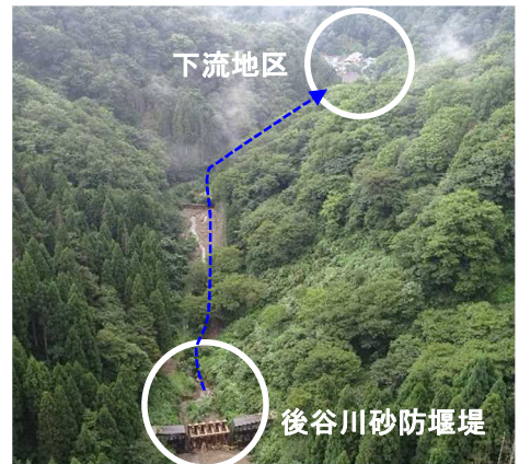
砂防堰堤で土砂及び流木を捕捉
