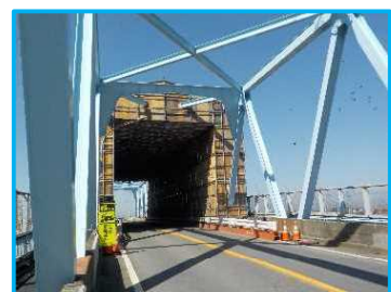
修繕(塗装塗替)状況 【米原跨線橋】
