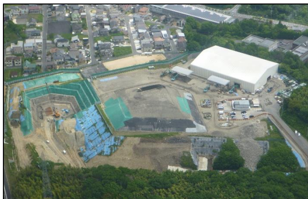
工事中（平成 28 年 5 月）の旧処分場
