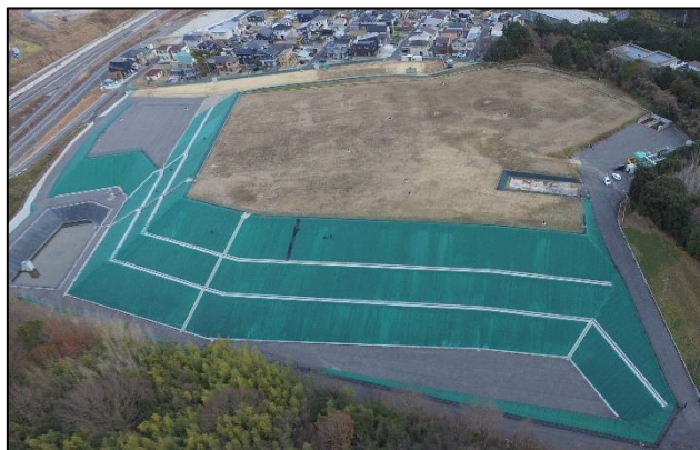
現在（令和 5 年 1 月）の旧処分場
