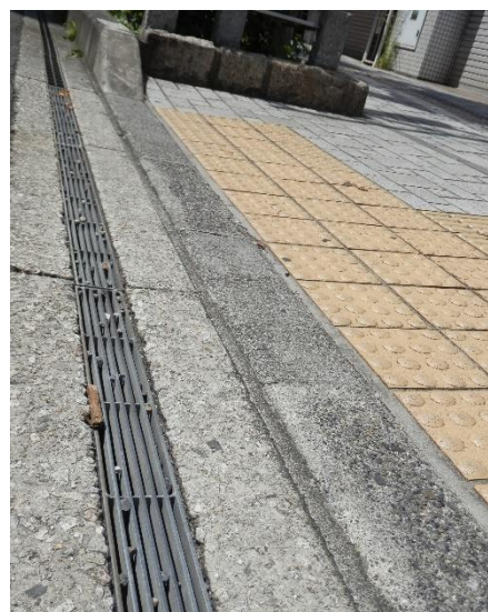
画像6 車道との段差に配慮した歩道
