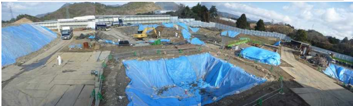
掘削状況 (平成 25 年 1 月撮影)
