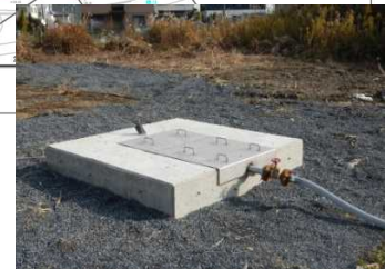
揚水井戸設置
