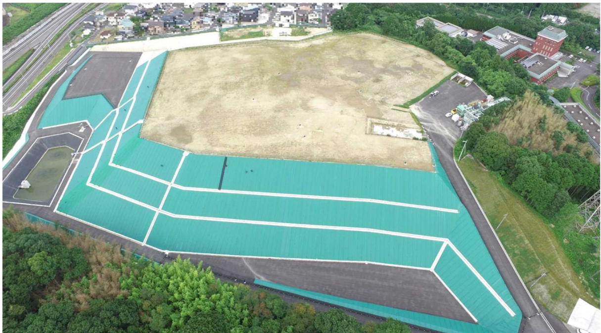
事案地の状況(対策工事後)
