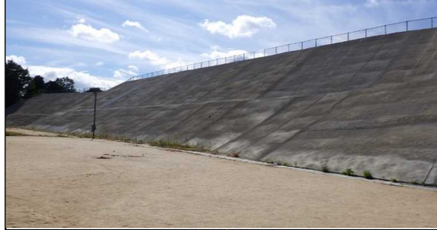
北尾団地側広場の法面(モルタル塗り)
