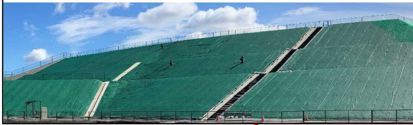
バイパス側法面(キャッピングシート張り)
