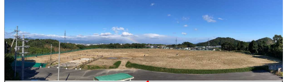
天端部の状況
