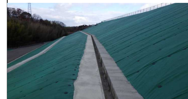
西市道側法面(キャッピングシート張り)
