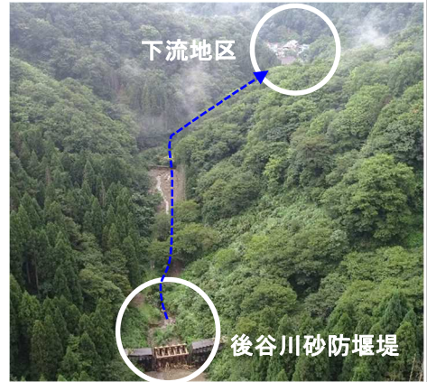
砂防堰堤で土砂及び流木を捕捉
