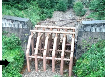
砂防堰堤で土砂及び流木を捕捉
