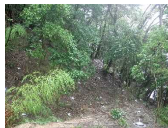
巨木、高木を残した工法
