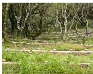
県産材を用いた丸太筋工
