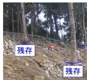
巨木等の残存状況
