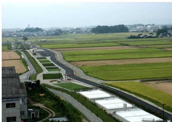
山寺川流域市街地排水浄化対策施設（伯母川ビオ・パーク）
