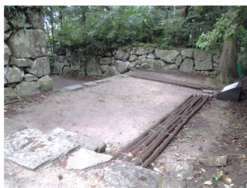
図 5-6 黒金門跡水たまり（仮設木道設置状況）
