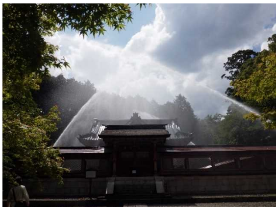
設置した消火設備の放水訓練
