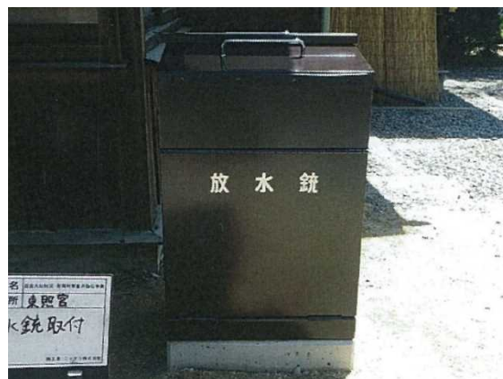
消火設備 放水銃の設置
