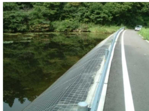
図VII-6 安全ネットの設置例
