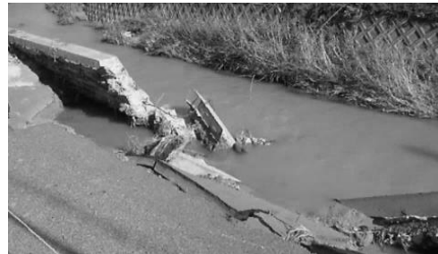
図 9 大戸川沿岸における国道の陥没
