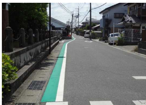
図1 グリーンベルト(八幡小学校前)
