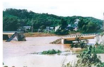
大戸川 1982(S57)年8月出水被害写真(石居橋)
