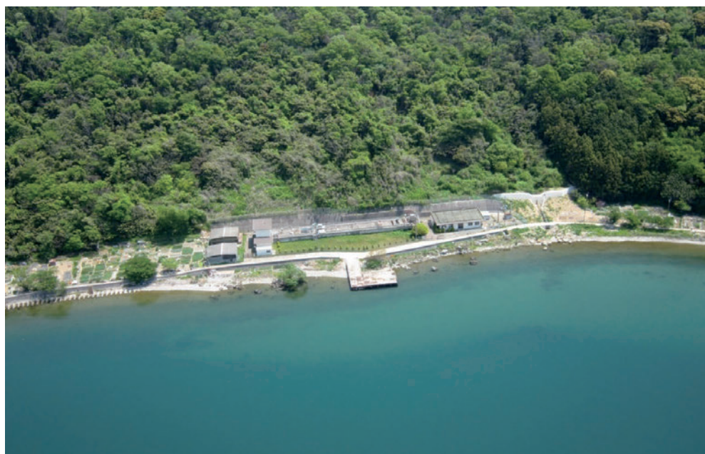
▲近江八幡市沖島浄化センター
