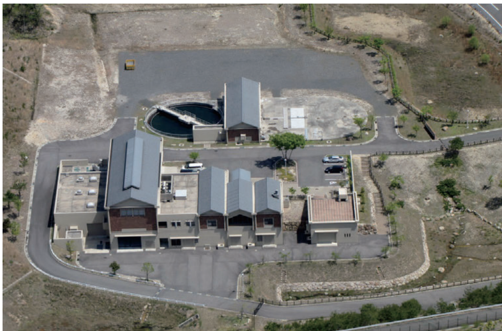
▲甲賀市信楽水再生センター
