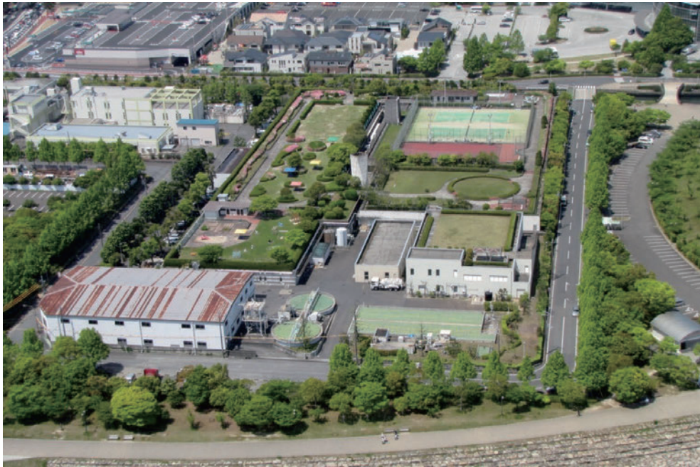
▲大津市水再生センター
