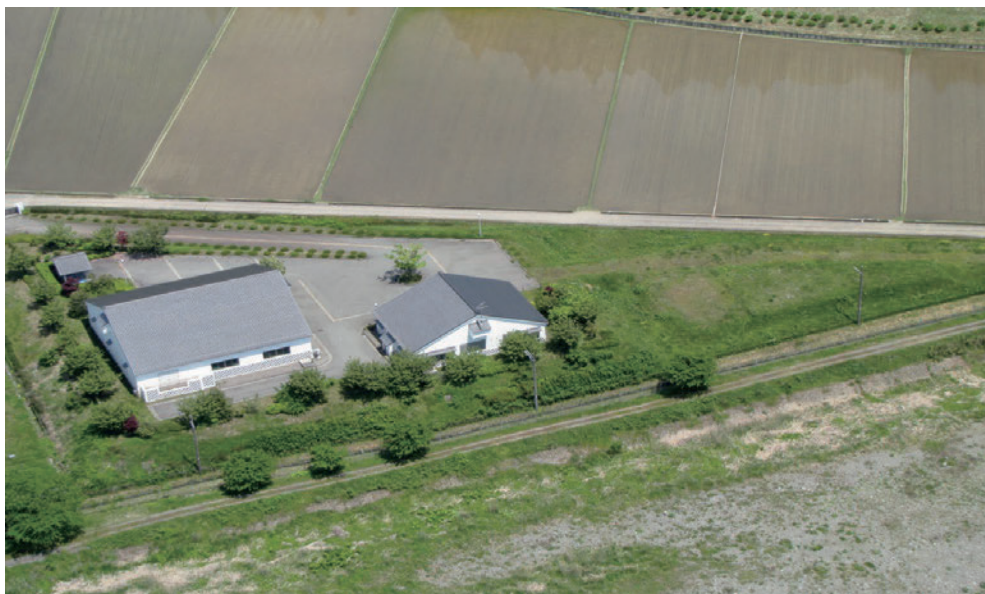
▲高島市朽木浄化センター
