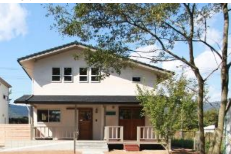
びわ湖材を使用した住宅
