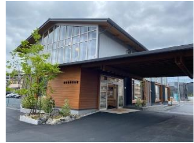
滋賀県林業会館
