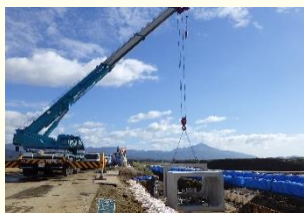
ボックスカルバート掘付状況
