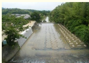
河川工事完了状況
