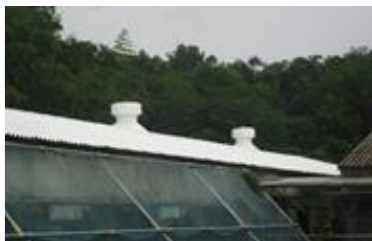
屋根への消石灰の塗布
