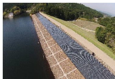
ため池法面での太陽光発電の設置
