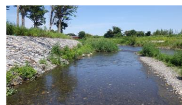
石田川多自然川づくり (環境保全カゴ型護岸) (高島市今津町福岡他)
