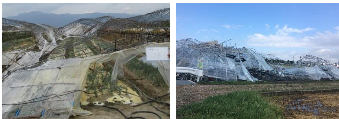
図 4-4 平成 30 年台風 21 号による農業用ビニールハウスの倒壊
