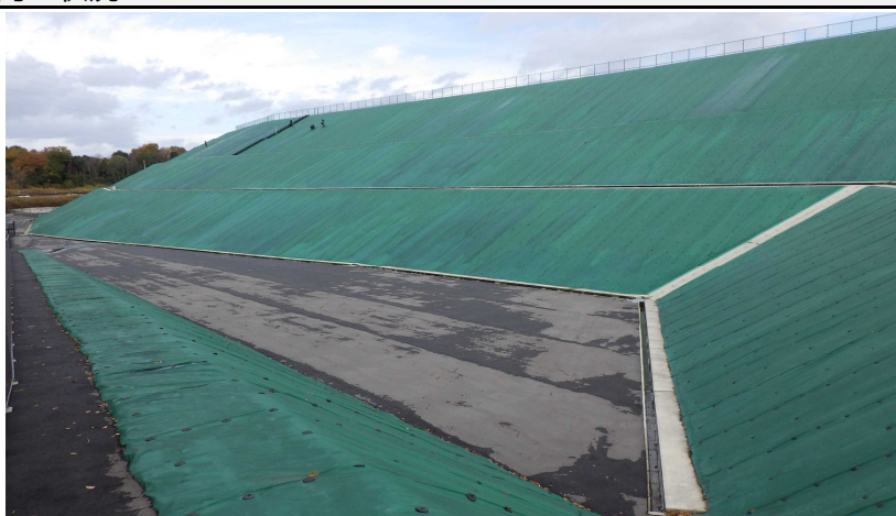
写真① 西市道側の様子
