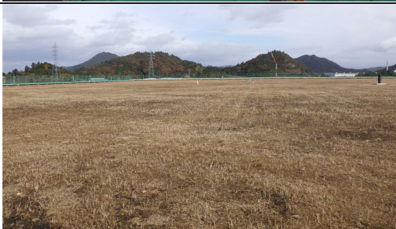
写真② 天端部の様子
