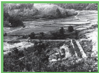
⑪ 甲賀市：大原貯水池
