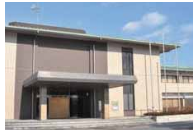
滋賀県平和祈念館の外観
