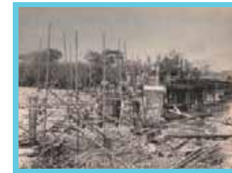
⑱ 長浜市：橋をかける工事現場
