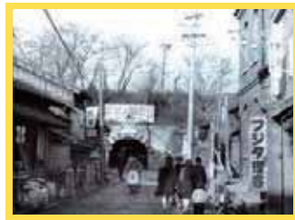
⑥ 草津市：草津川トンネル
