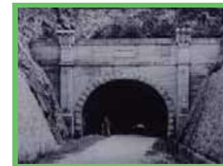
㉔ 甲賀市：鈴鹿峠 国道1号線のトンネル
