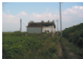
▲ 水はポンプでくみ上げてぬいていた。いまもポンプ小屋が残っている。
